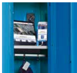
Armoire-vestiaire avec module électrique
